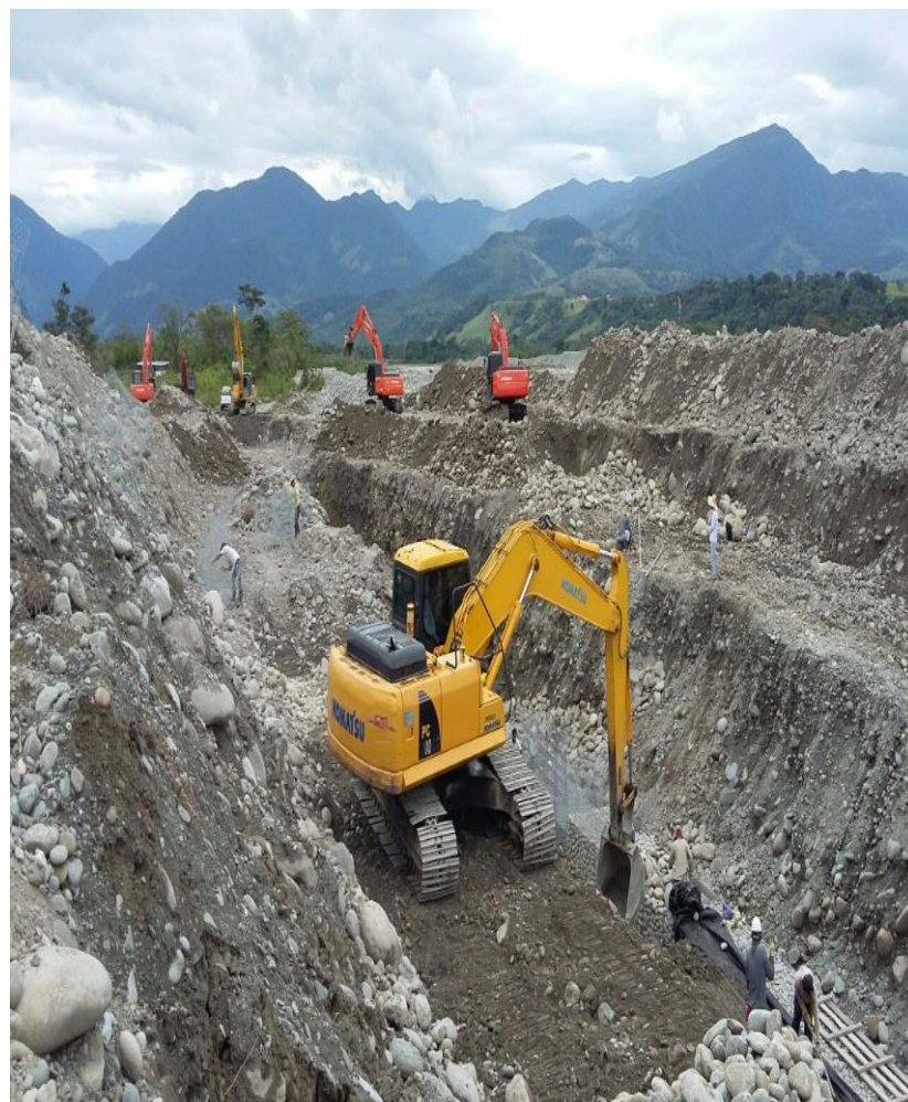
OBRAS DE MITIGACION VIAL
